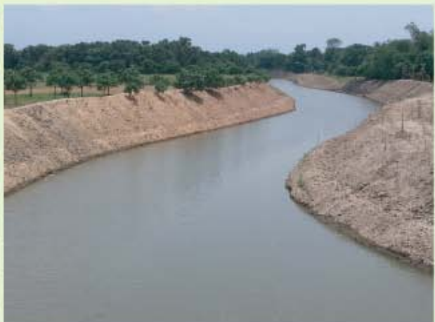
খাল খনন কার্যক্রম
